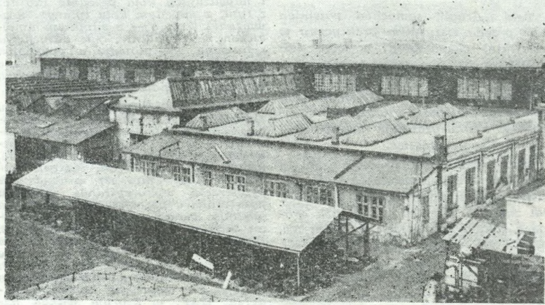
Zabudowania starej Kuźni Ustronia
