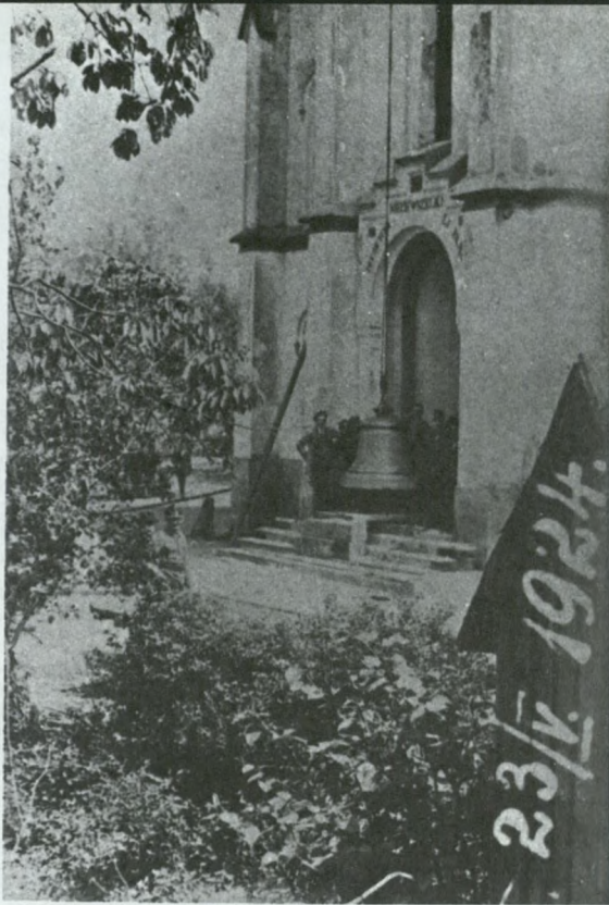
60. Podnoszenie dzwonów pod kier. mistrza fabr. Jerzego Lipowczana na wieżę kościoła ewangelickiego. Fot. 23.05.1924.
