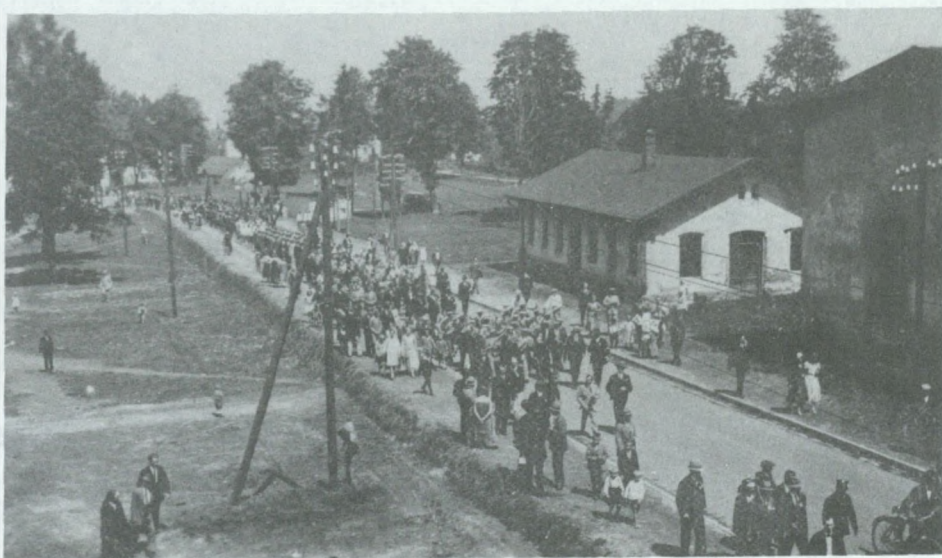
16. Fragment dawnej huty przebudowanej po r. 1945 i przeznaczonej na Zespół Szkół Kuźniczych przy ul. 3 Maja 15. Poniżej wyburzony domek fabryczny. Na drodze pochód na otwarcie domu spółdzielczego przy ul. Partyzantów 1. Fot. 28.06.1931.
