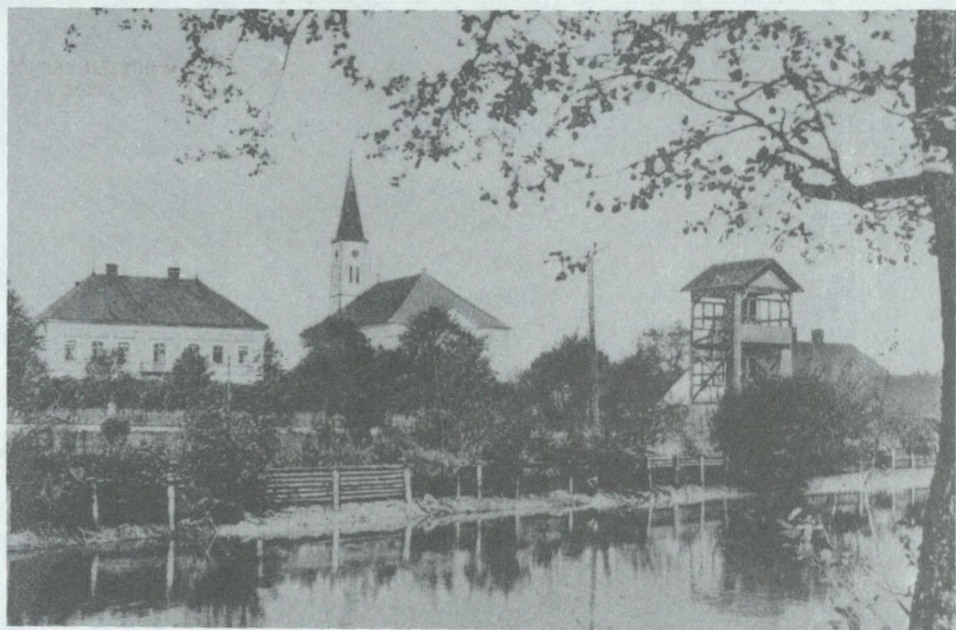
7. Obecny gmach Urzędu Pocztowego, kościół ewangelicki, wieża do ćwiczeń Straży Pożarnej, restauracja (wyburzona po r. 1945) i remiza strażacka (wyburzona). Fot. z r. 1905.
