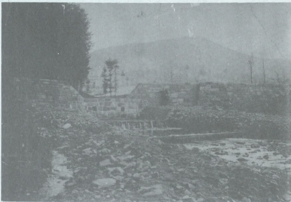
25. Zapora wodna na potoku Poniwiec. Po Prawej J. Wantuła pod którego dozorem zaporę zbudowano. Fot. z r. 1927.
