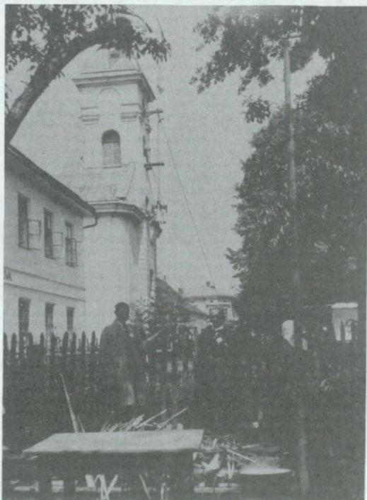
61. Podnoszenie dzwonów na wieżę kościoła katolickiego. Fot. ok. r. 1924.
