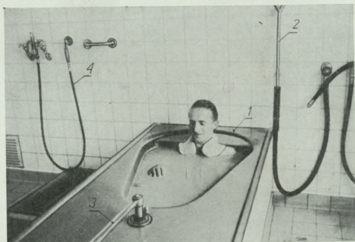
Rys. 7-58. Wanna do kąpielei w szlamie morskim (uzdrowisko Westerland) 1 — kotnierz stanowiący część wanny, zabezpieczający przed wypieraniem ciała ze szlamu kąpielowego, 2 — przyrząd do dodatkowego ogrzewania szlamu w wannie, 3 — dźwignia do uruchamiania dopływu szlamu, 4 — bateria z węzłem natryskowym
