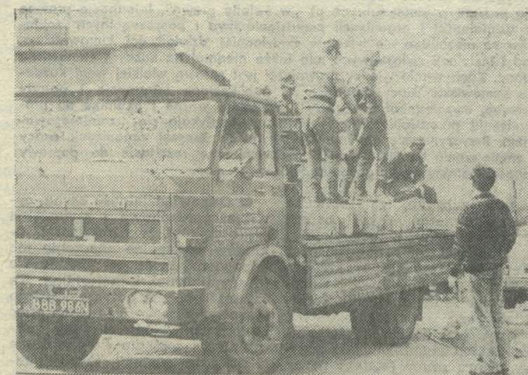
W najcięższych pracach przy układaniu krawężników wzdłuż ulicy Greczki cenną pomocą posłużyli żołnierze LWP.
