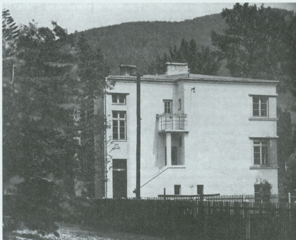
Willa Anny i Pawła Michejdów w Ustroniu przy obecnej ul. Parkowej 8, 1932 r. (fot. pochodzi z miesięcznika „Architektura i budownictwo” nr 5/1932)
