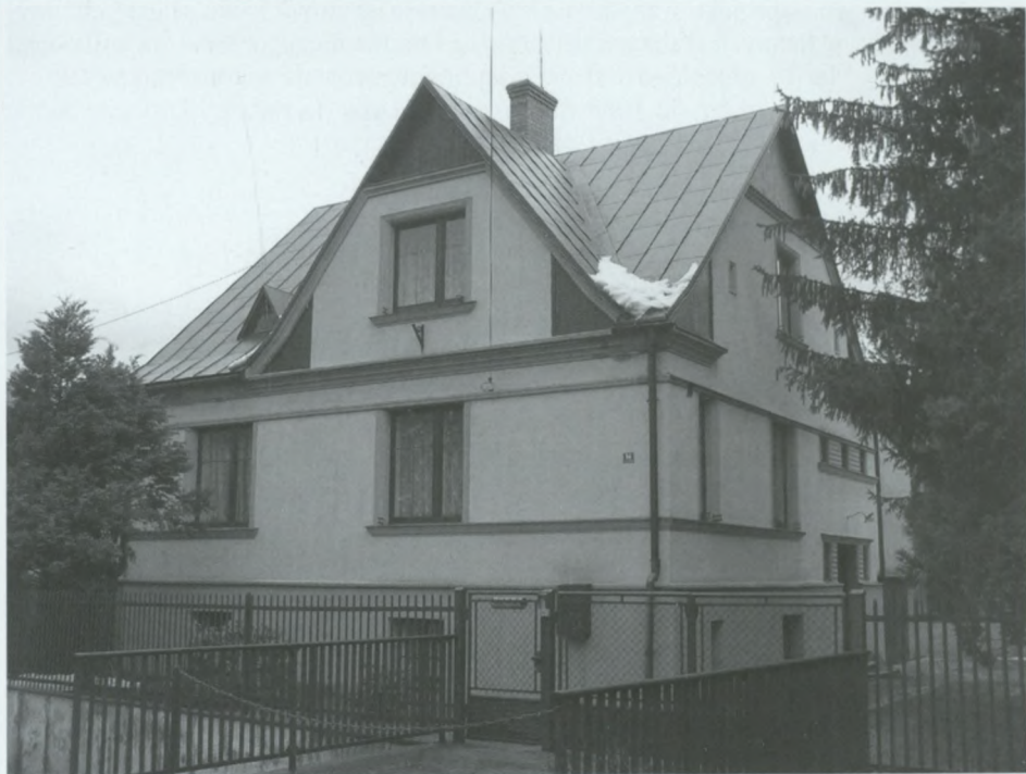
Luty 2007 r. Willa „Relijanka” – współcześnie. Dom przy ul. 9 Listopada 14 widnieje w ewidencji zabytków miasta Ustroń pod pozycją 254 (fot. Dominik Konarzewski)
