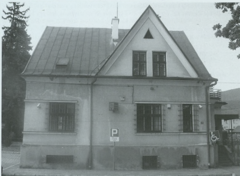
Była siedziba Banku Spółdzielczego w Ustroniu przy ul. Partyzantów 5, 26 lipca 2006 r. (fot. Tomasz Błahut)
