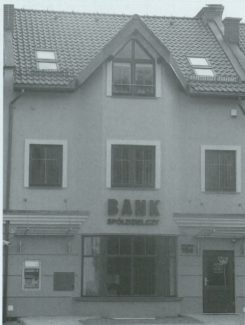
Obecna siedziba Banku Spółdzielczego w Ustroniu, 26 lipca 2006 r. (fot. T. Błahut)
