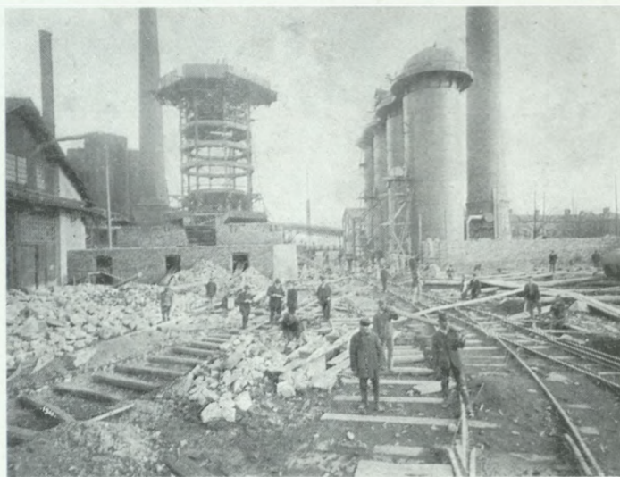
Zahájení výstavby vysoké pece III
