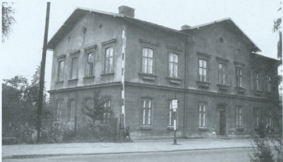
Budynek przy obecnej ul. I. Daszyńskiego 61 przejawia cechy oszczędnej austriackiej architektury mieszkalnej. Uwagę zwracają zachowane do dzisiaj w części poddasza proste dekoracje – młotki kuźnicze, krzyżyki równoramienne oraz oculusy. Lata 60. XX w. (archiwum Muzeum Ustrońskiego)
