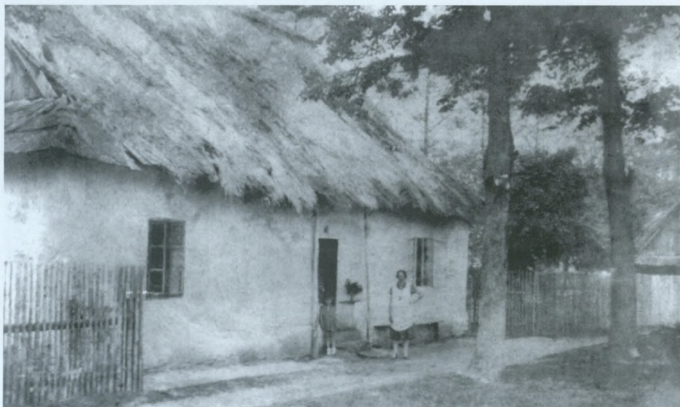
Chociaż krajobraz Ustronia na przestrzeni XIX w. bardzo się zmieniał, a budowle murowane wypierały drewniane, niektórych domów nie naruszył żąb czasu i dzisiaj są zabytkami – lokalnymi „perełkami”. Na fotografii z przełomu lat 20. i 30. XX w. uwieczniono dom nr 21, obecnie stojący przy ul. Bocznej 9 w Ustroniu Nierodzimiu. Częściowo murowany, częściowo drewniany, z charakterystycznymi „przilypkami”, pochodzi z końca XVIII w. Dawniej kryty był słomą, a dzisiaj papą (archiwum rodzinne Klaudiusza Spiloka)
