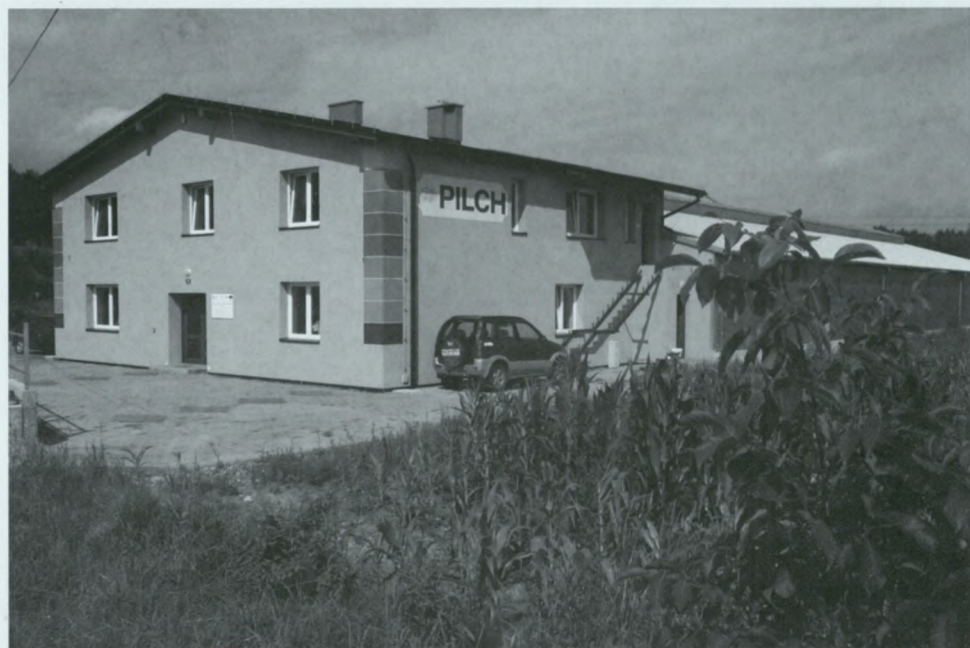
Nowy budynek głównej siedziby Zakładu Produkcyjno-Handlowego Pilch w Ustroniu przy ul. Fabrycznej 36, otwarty w marcu 2011 r. (fot. Michał Pilch, 19 lipca 2011 r.)
