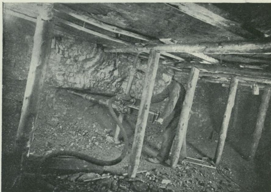
Rys. 8. Robienie wrębu wrębówką słupową.
