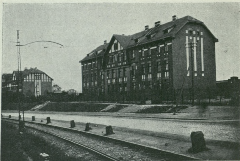
Ryc. 24. Domy mieszkalne dla urzędników Kopalni Niemcy przy ul. Wireckiej w Świętochłowicach.
