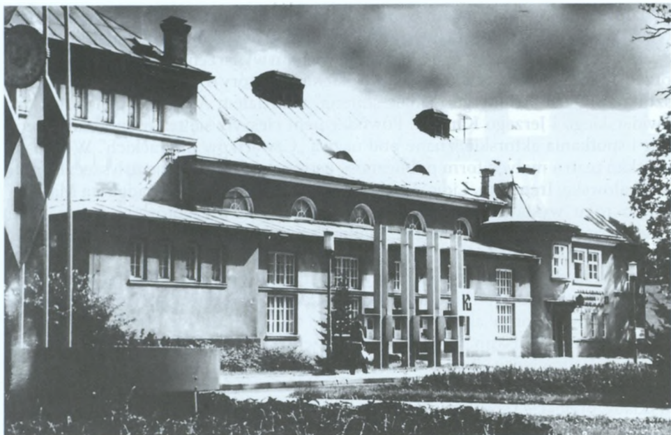
Zakładowy Dom Kultury „Kuznik”, lata 70. XX w. – widok od strony zachodniej
