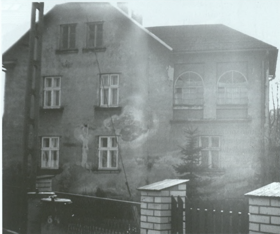
Dom przy ul. Ogrodowej 5, 1995 r. Widok od strony północnej
