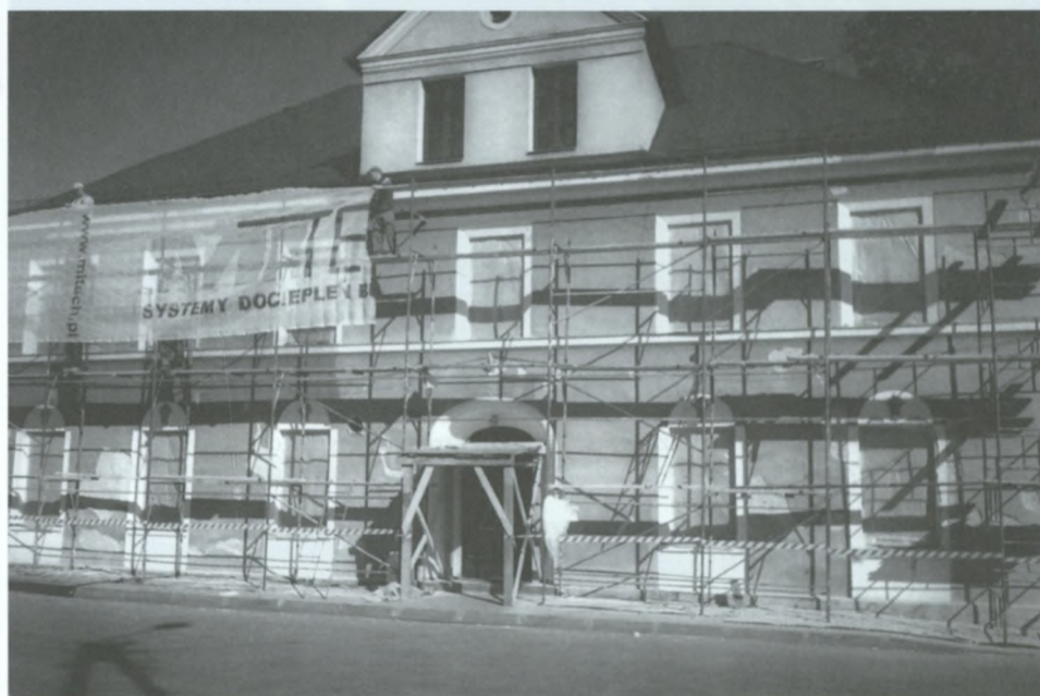
Remont elewacji południowo-zachodniej części budynku „Prażakówki” – od strony ul. Strażackiej i ul. Ignacego Daszyńskiego (niewidoczny na zdjęciu), 2006 r. Zbiory własne MDK „Prażakówka”
