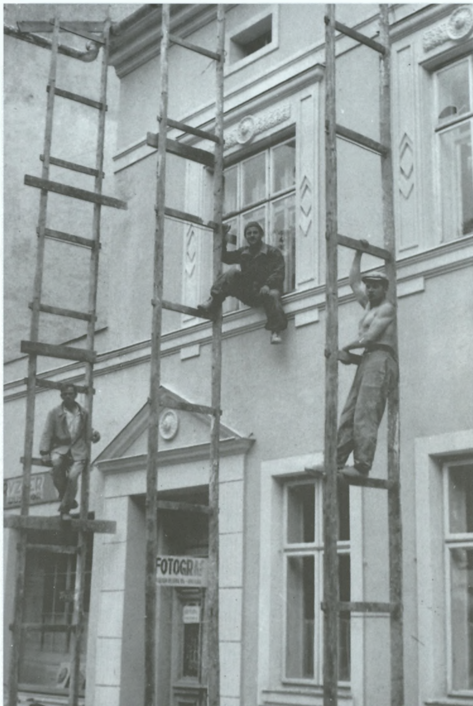
Odnawianie fasady kamienicy rodziny Silbermannów przy ówczesnej ul. 22 Lipca 58 (dziś ul. Ignacego Daszyńskiego 4), lata 70. XX w.
