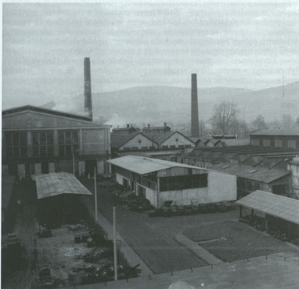
Zabudowania Zakładów Kuźniczych w Ustroniu. Od lewej: kuźnia parowa, stare obiekty kuźni parowej, hartowni i matrycowni. W tle kominy kotłowni. Z przodu wiata dla kuźniarek. Początek lat 60. XX w. (zbiory Muzeum Ustrońskiego im. Jana Jarockiego)
