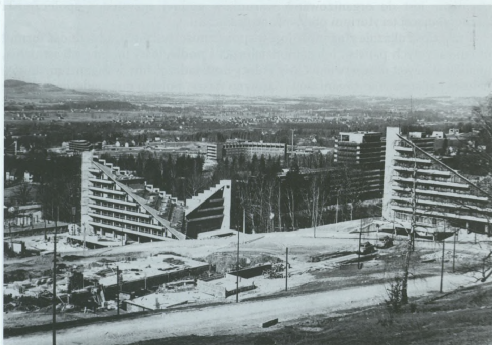
Ustroń, lata 70. XX w. Budowa domów wczasowo-sanatoryjnych, tzw. piramid w dzielnicy Zawodzie (zbiory Korneliusza Świątko)
