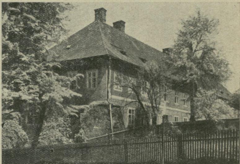
Budynek Gimnazjum ewangelickiego i szkoły ludowej w Cieszynie.
