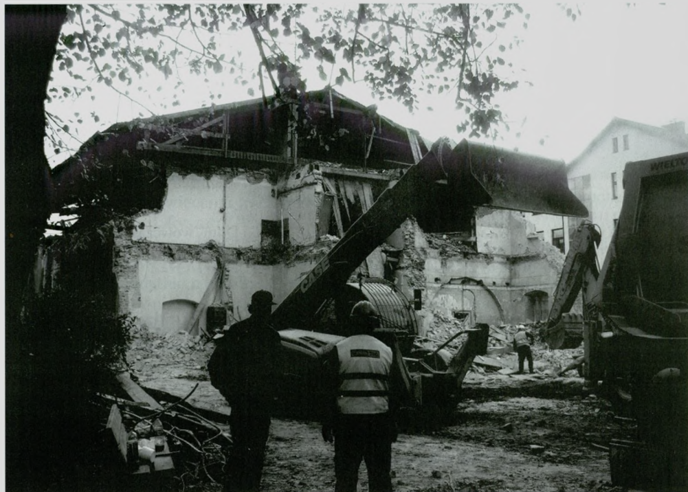
Rozbiórka „Starego Domu” w listopadzie 2012 r. odsłoniła cechy stylowe dawnego warsztatu maszynowego. Ustroń utracił wówczas ponad 170. letni zabytek
