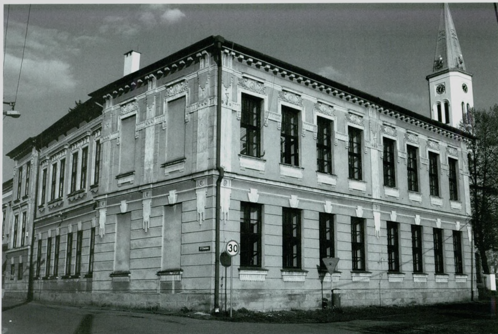
Zabytkowy obiekt szkoły przy ul. Stawowej 3 – ujęcie współczesne od północnego-zachodu. Fot. Michał Pilch, 2 maja 2015 r.
