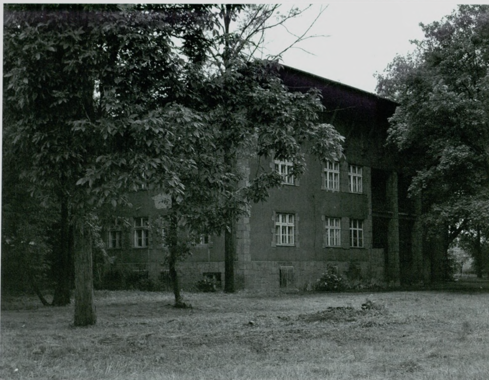
Stacja harcerska w Górkach Wielkich Sojce – Dom Kursów, stan obecny. Fot. Dorota Greń
