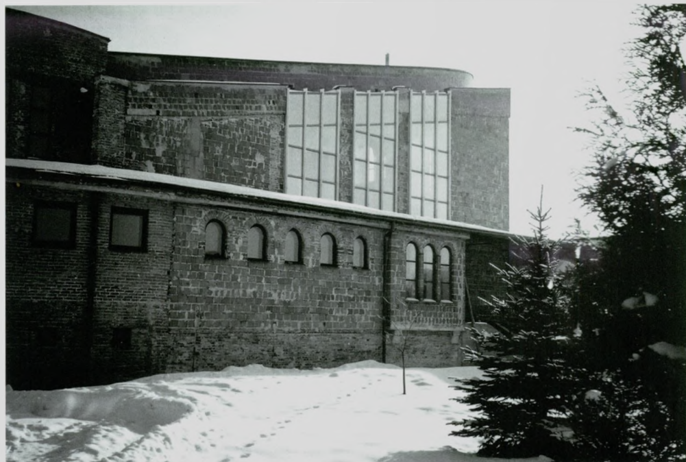
Budowa kościoła rzymskokatolickiego pw. Najświętszej Maryi Panny Królowej Polski oraz klasztoru Ojców Dominikanów w Ustroniu Hermanicach, lata 90. XX w. Archiwum rodzinne Rozalii Piotrowskiej-Raszki
