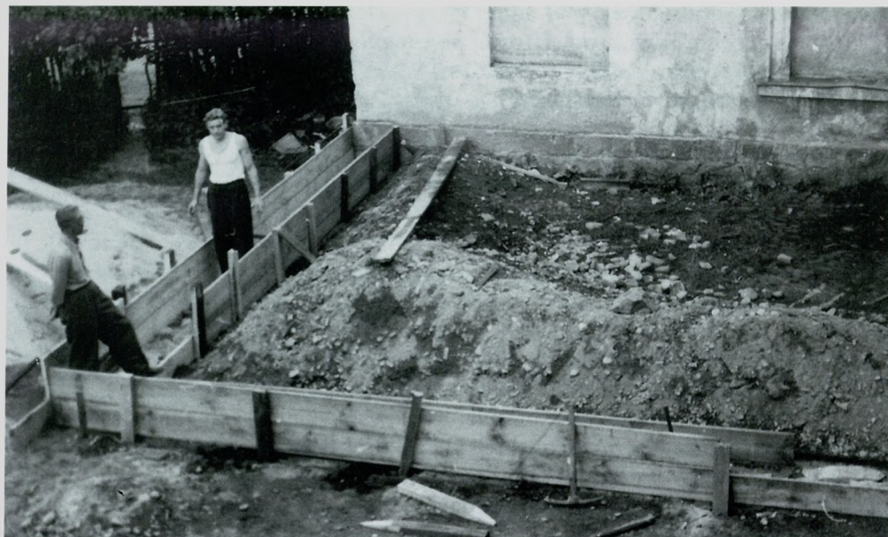
Rozbudowa szkoły od strony południowo-wschodniej – wykonywanie fundamentów, 1953 r. Archiwum rodzinne Krystyny Szlauer
