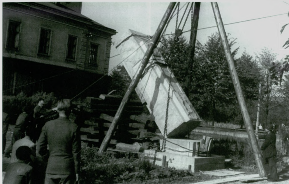
Wciąganie kamiennego bloku – już po obróbce przez kamieniarzy z Brennej – na miejsce przeznaczenia, wiosna 1948 r. Fot. Józef Cywiński
