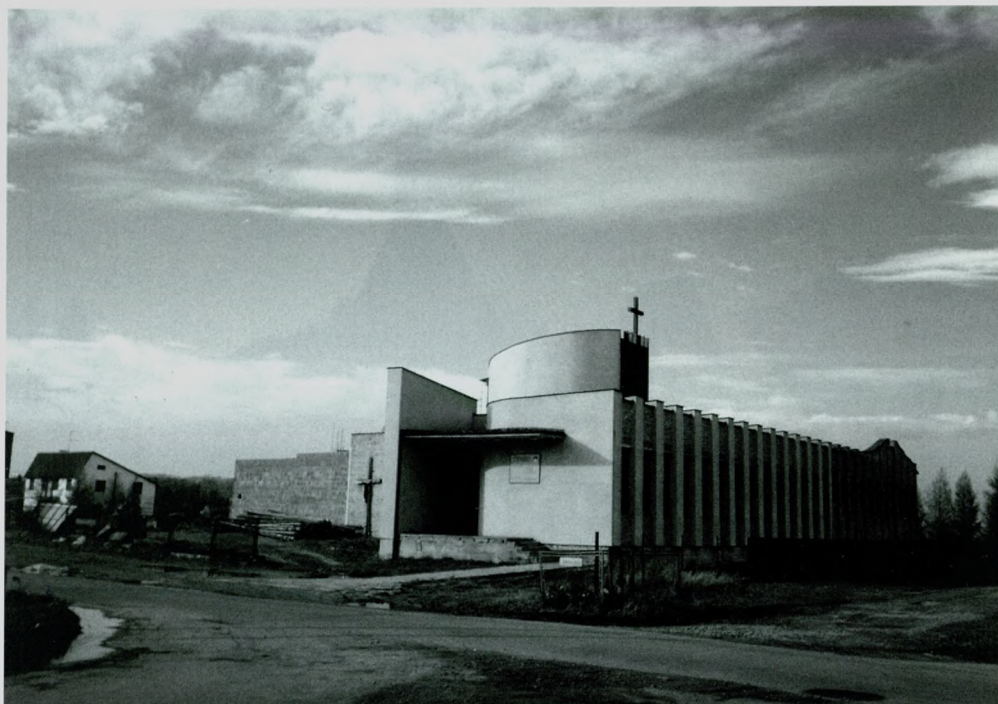
Budowa kościoła rzymskokatolickiego pw. Najświętszej Maryi Panny Królowej Polski oraz klasztoru Ojców Dominikanów w Ustroniu Hermanicach, lata 90. XX w. Archiwum rodzinne Rozalii Piotrowskiej-Raszki
