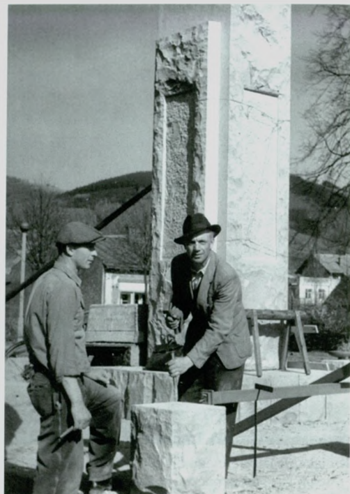
Wykwalifikowani kamieniarze z Brennej przystępują do obróbki 12 kamiennych cokolików (słupków), wiosna 1948 r. Fot. Józef Cywiński
