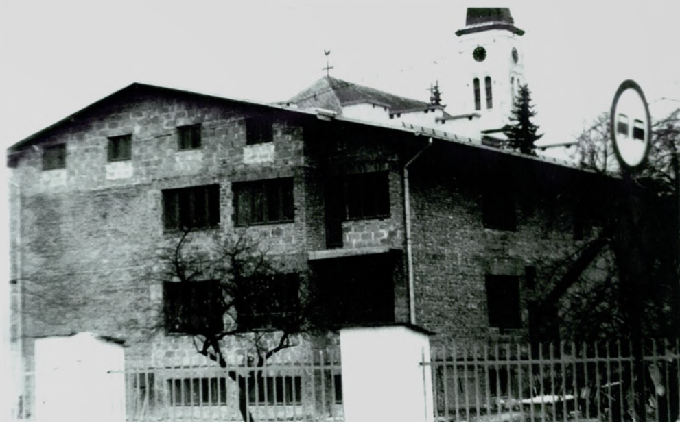
Budowa Domu Parafialnego w Ustroniu, 4 listopada 1984 r. Widok od strony północno-wschodniej. Fot. Władysław Fabian, Ustroń ( www.fotopolska.eu )
