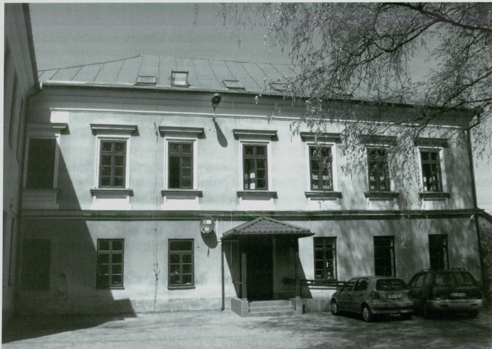
Widok na szkołę od strony południowej. Tutaj pierwotnie znajdowało się główne wejście do budynku. Fot. Bożena Kubień, 24 kwietnia 2015 r.
