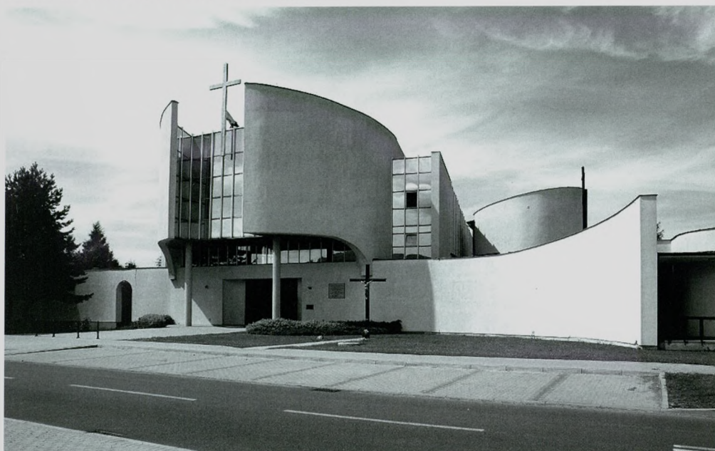
Kościół rzymskokatolicki pw. Najświętszej Maryi Panny Królowej Polski oraz klasztor Ojców Dominikanów w Ustroniu Hermanicach. Obiekt zrealizowany w latach 1982-2001 według projektu Zbigniewa Koldera i Henryka Raszki (konstrukcja). Fot. z 23 czerwca 2012 r., ze strony internetowej: www.fotopolska.eu
