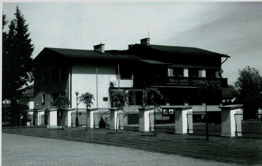
Dom Parafialny Parafii Ewangelicko-Augsburskiej w Ustroniu. Obiekt zrealizowany w latach 1983-1985 według projektu Edwarda Kisiela i Henryka Raszki (konstrukcja). Widok od strony południowo-zachodniej. Fot. Bożena Kubień, 12 maja 2015 r.
