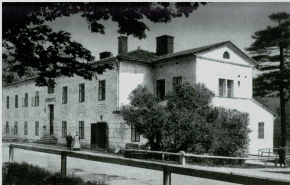
Kurhotel po wykonanym remoncie w 1910 r. ZMU
