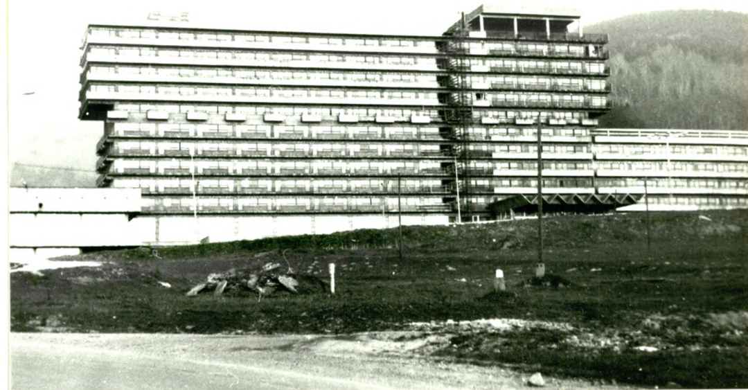
Sanatorium w budowie
