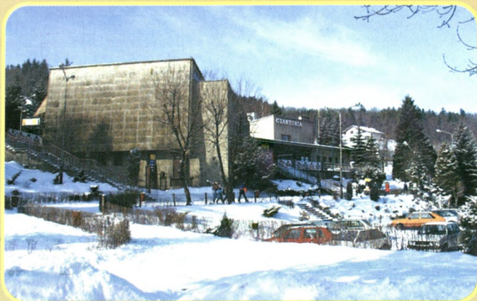
Stacja dolna Kolei Linowej
