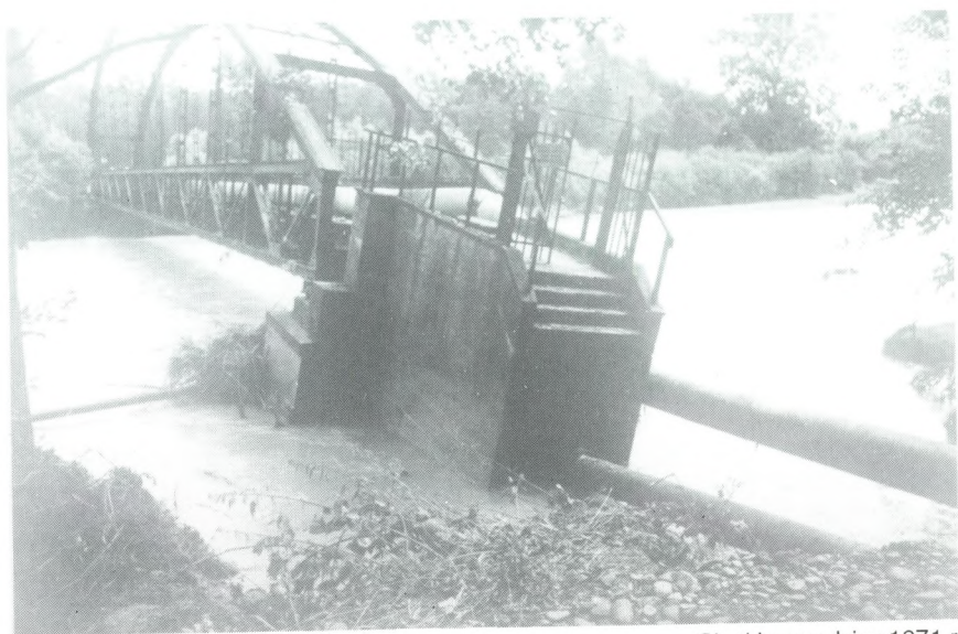
Skutki powodzi w 1971 r. Následky povodně
