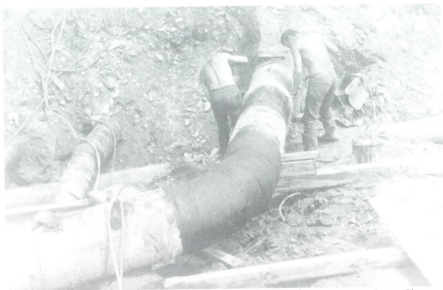
Budowa magistrali \phi 500 mm (Pogórze - Cieszyn) Stavba přivaděče \phi 500 mm
