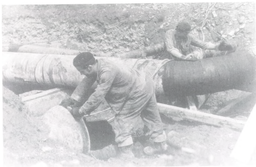
Budowa magistrali \phi 500 mm (Pogórze - Cieszyn) Stavba přivaděče \phi 500 mm
