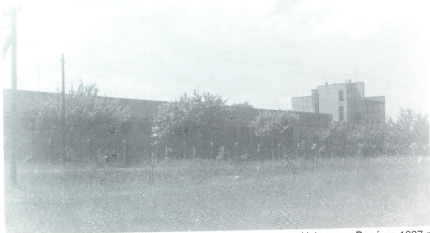
Hala pomp Pogórze 1937 r. Hala čerpadel
