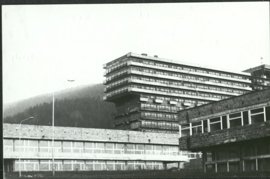
SANATORIUM W BUDOWIE
