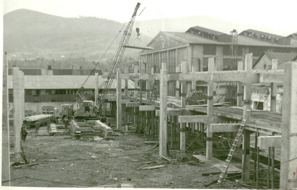
Budowa nowej hali Osprzętu w ustronieńskiej "Kuzni" - 1968 rok
