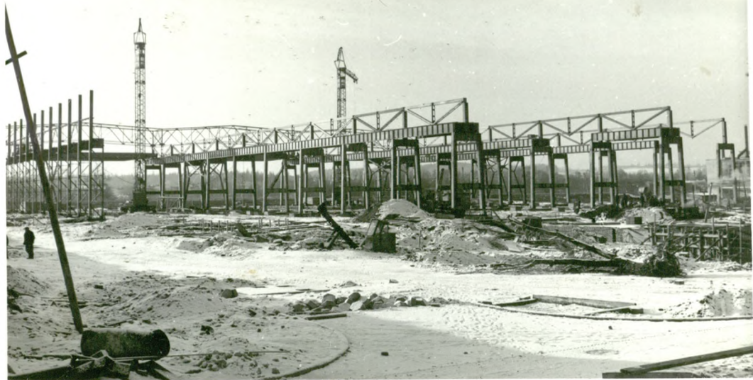
Budowa nowej kuźni w Skoczowie - lata sześćdziesiąte.
