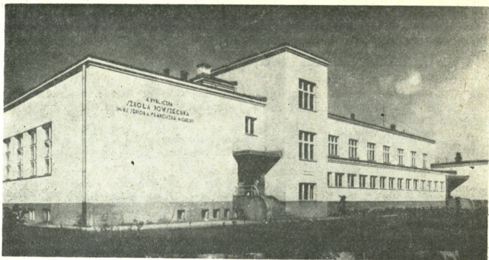
Nowa szkoła w Wiśle Głębcach zbudowana w 1937 r.
