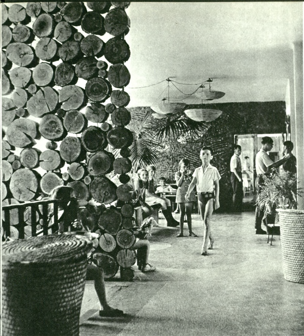
Hall domu wczasowego „Zagłębie”
