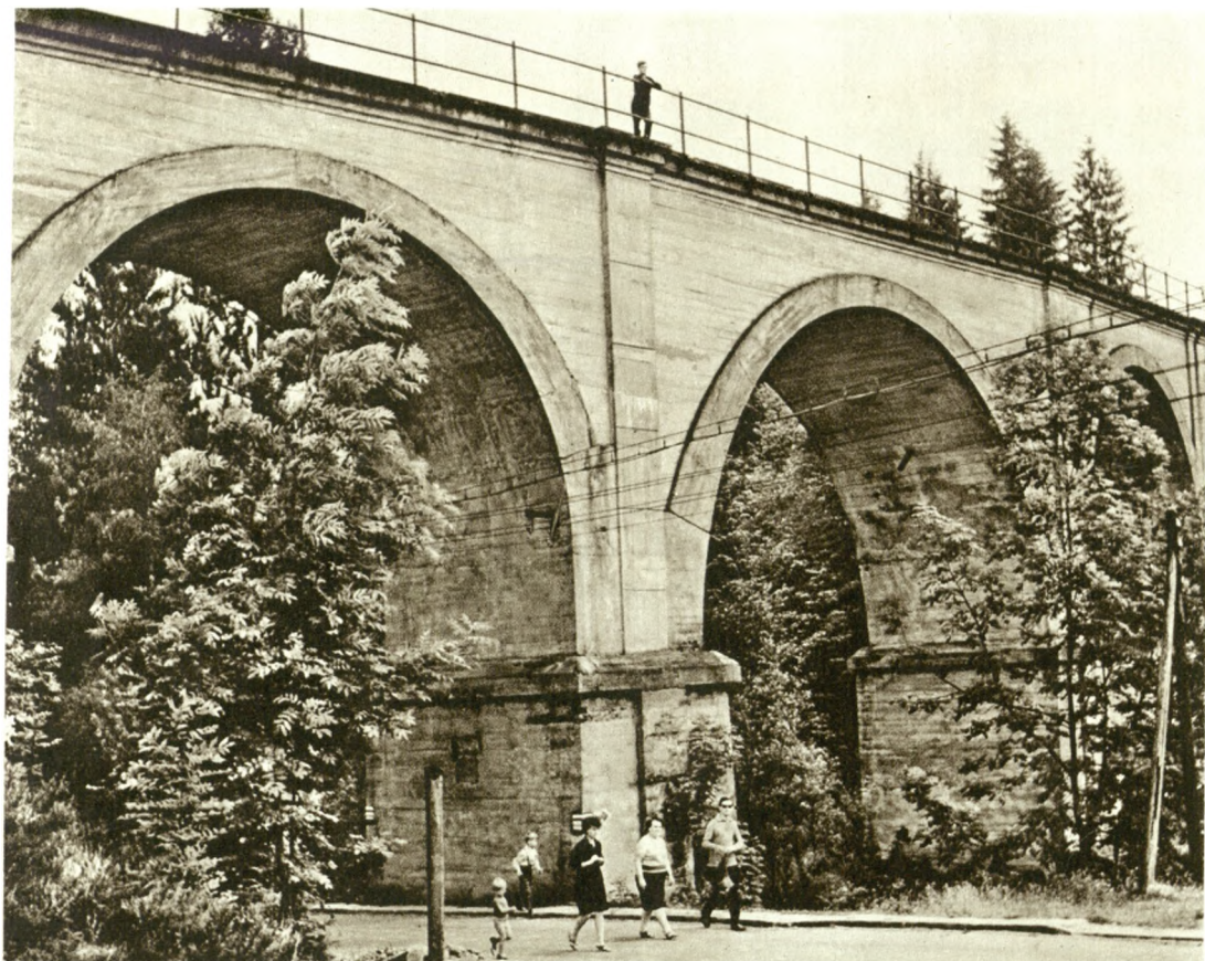
Most kolejowy w Wiśle-Głębach
