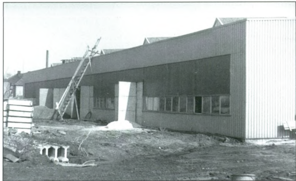
Prace wykończeniowe hali warsztatowej.
