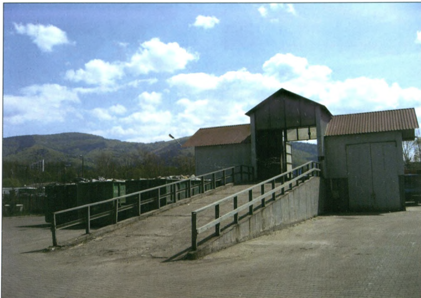
Stacja przeładunkowa odpadów komunalnych w Ustroniu wraz z zapleczem do gromadzenia surowców wtórnych.
