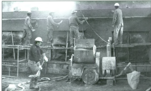
Tynkowanie hali warsztatowej.
