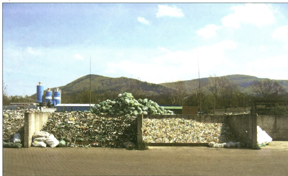
Boksy na szkło białe, kolorowe i azbest na stacji przeładunkowej odpadów komunalnych.
