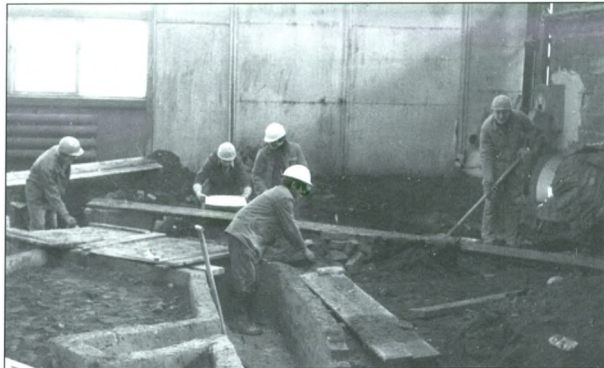
Budowa hali warsztatowej.
