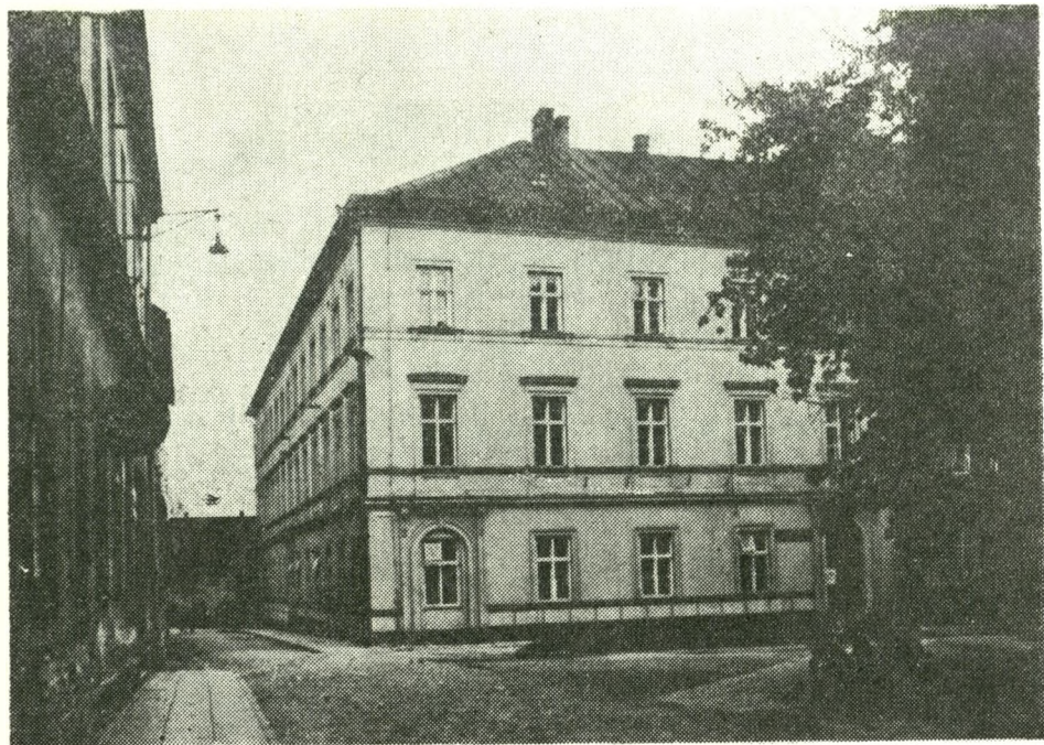
Budynek przy pl. Dominikańskim zajmowany przez Szkołę Handlową w latach 1936—48.
