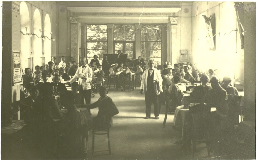
HOTEL KURACYJNY - Restauracja
