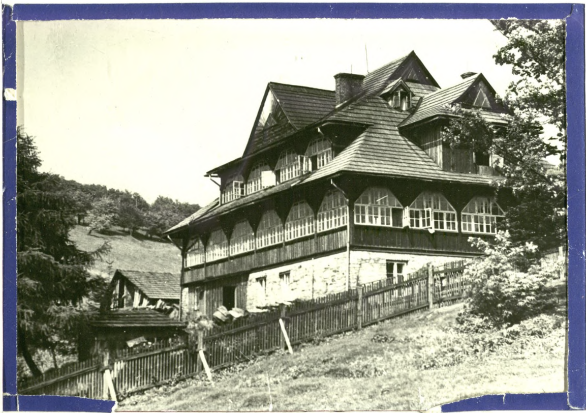
Schronisko na Rownicy
