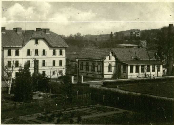
Ustroń, Zakłady kąpielne borowinowych.
