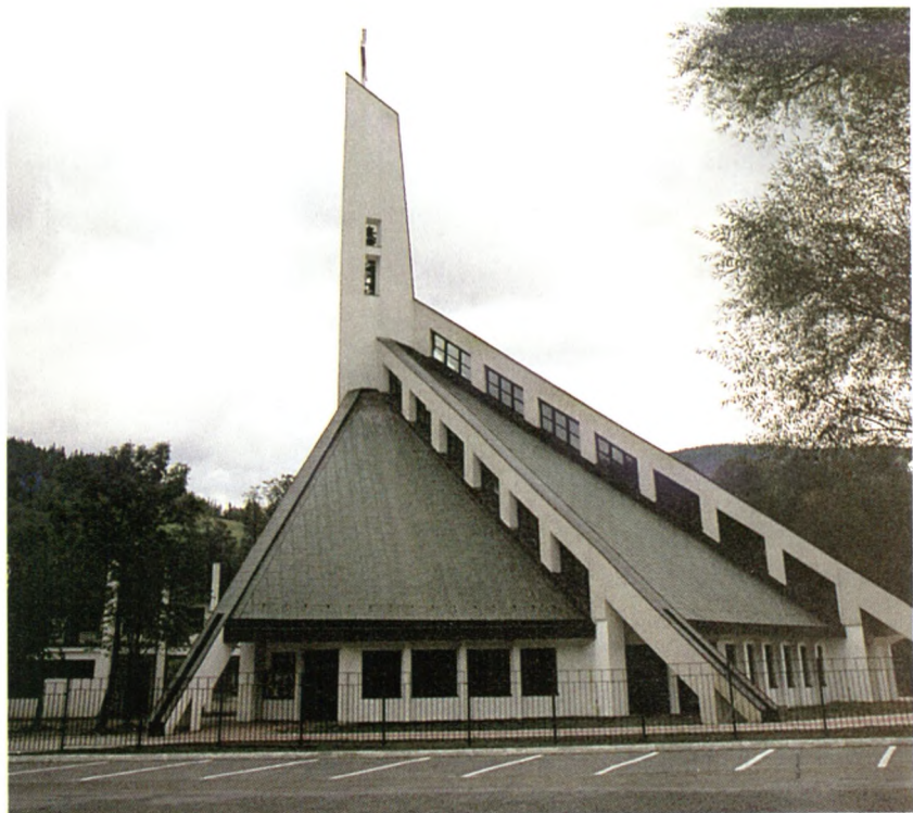
5. Kościół od strony wejścia bocznego
