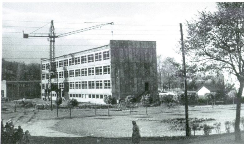
Końcowe etapy budowy, 1962
